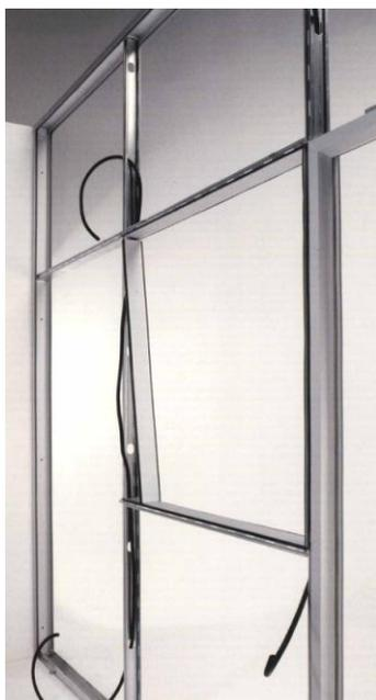
Struttura interna non apparente interamente costituita da profili trafilati in acciaio zincato composta da:
