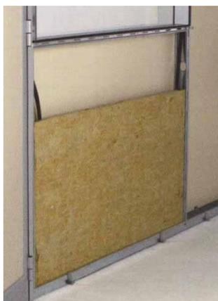
Lo spazio fra i due pannelli di tamponamento di mm. 70 può essere utilizzato anche per il posizionamento al suo interno dell'impianto elettrico, idrico, gas medicali e qualsiasi altra alimentazione di specifico utilizzo all'interno del laboratorio.
