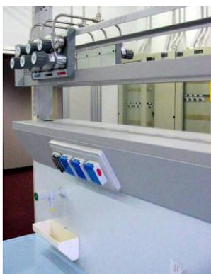
Realizzati in lamiera 15/10 trattata con verniciatura epossidica spessore 80 micron colore SILVER GOFFRATO RAL 9006, sono orientati con un'inclinazione di  $\sim 30^\circ$  nella direzione del piano di lavoro; la particolare sezione del profilo consente di contenere la sporgenza delle apparecchiature elettriche a beneficio di uno sfruttamento razionale di tutta la superficie del piano di lavoro.
